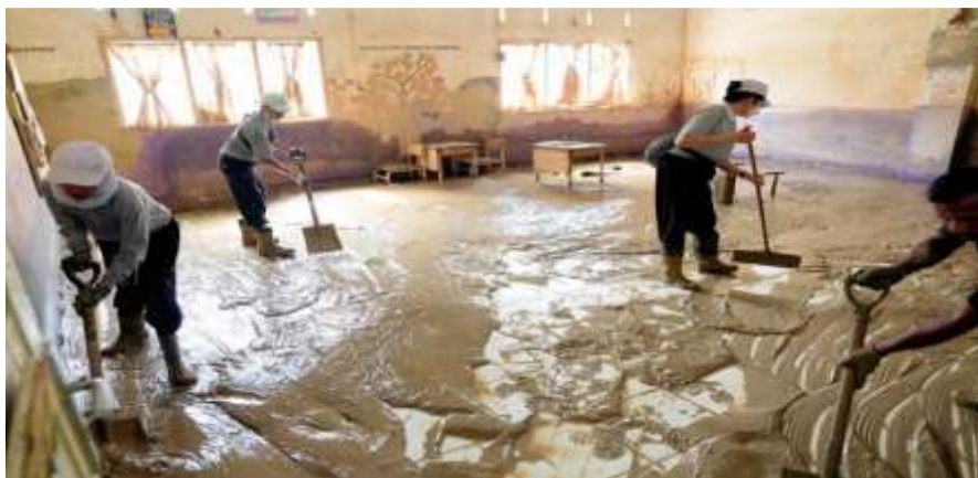
Gambar 4. Lumpur menutupi ruang kelas SDN 01 Bukit Tempurung, Kuala Simpang, Aceh Tamiang, 25 Desember 2025
