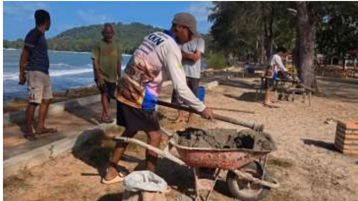
Gambar 2. Proses pembangunan spot foto
